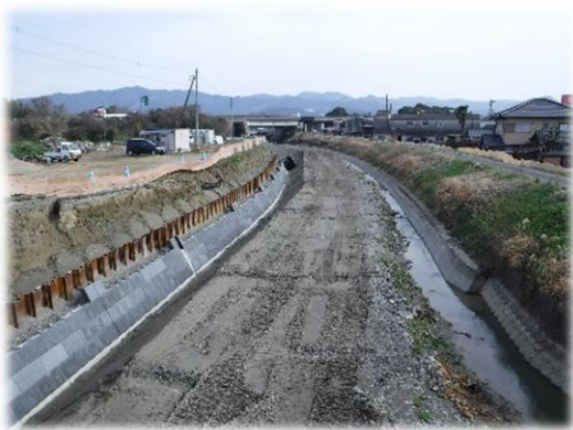
河川の改良工事
